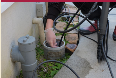
配管高圧洗浄
